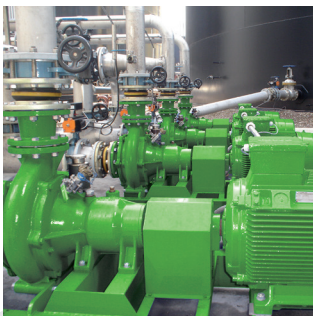
MAGNUM SX Dickstoffpumpe Getriebe- und Lagerstuhlausführung
